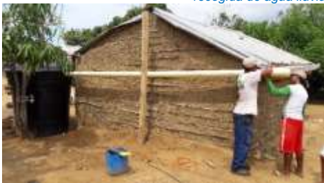
Proceso de instalación de sistema de recogida de agua lluvia
